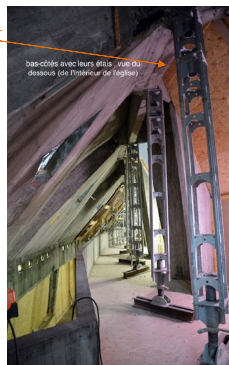
Coursives basses avec étais pendant les travaux
