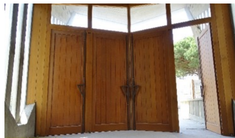
Porte vue de l'intérieur après pose
