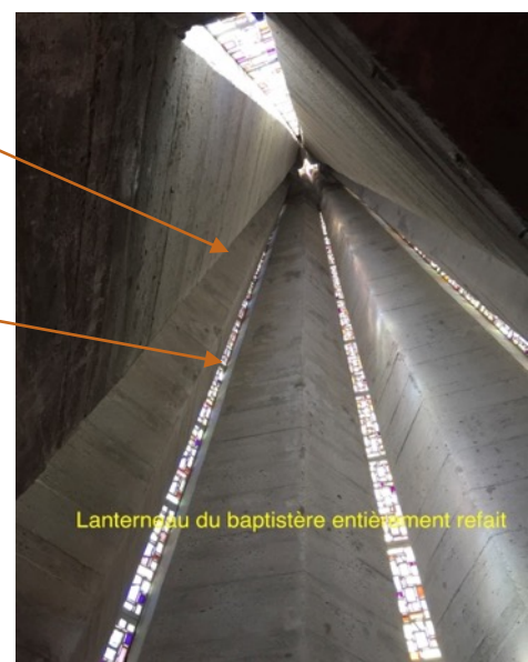
Lanterneau SUD – vue intérieure
