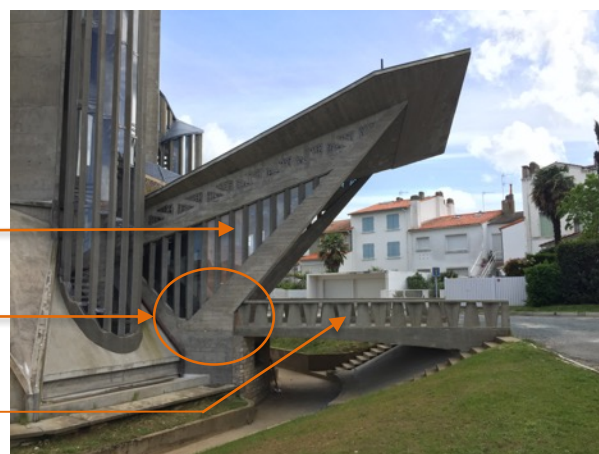
Pan latéral Zone d'ancrage des tirants Passerelle
