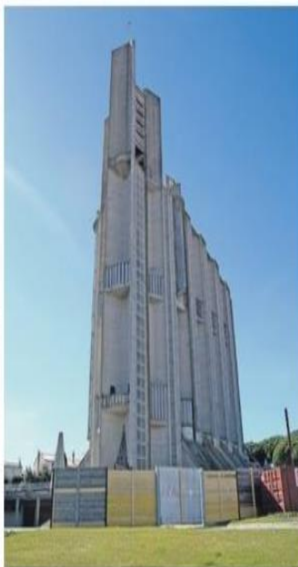
L'église Notre-Dame est actuellement en travaux.
