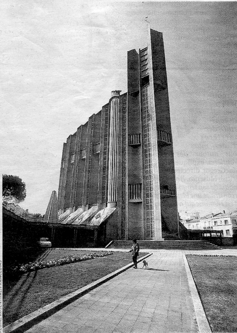
Notre-Dame de Royan. La mauvaise qualité du béton utilisé à l'époque de la construction a facilité l'oxydation de son armature de métal.
